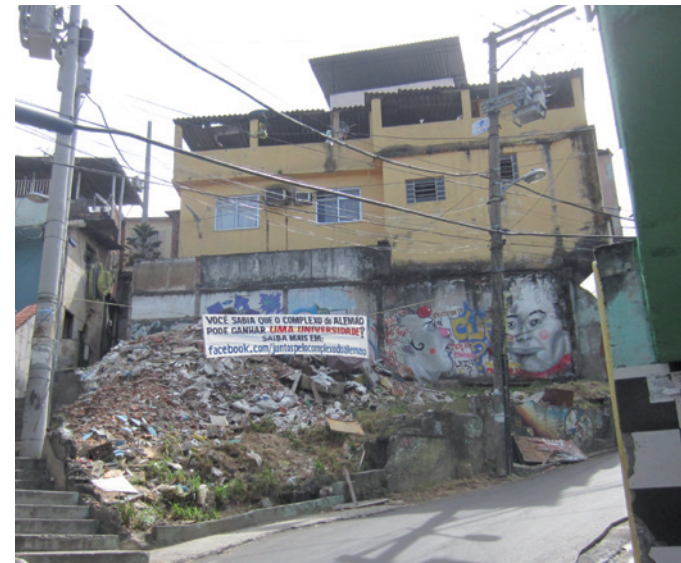
Fig.05: Entulho de casa demolida não removida. Foto: Solange Carvalho / 2015.
