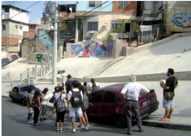
Fig.27: Solo impermeabilizado por proteção em concreto projetado. Obra do PAC na Av. Central. Foto: Rodrigo Codevila Palma/2015.
