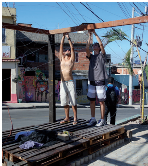
Fig.44: Passagem de arame na cobertura. Foto: Maria Rúbia Grillo/2015.
