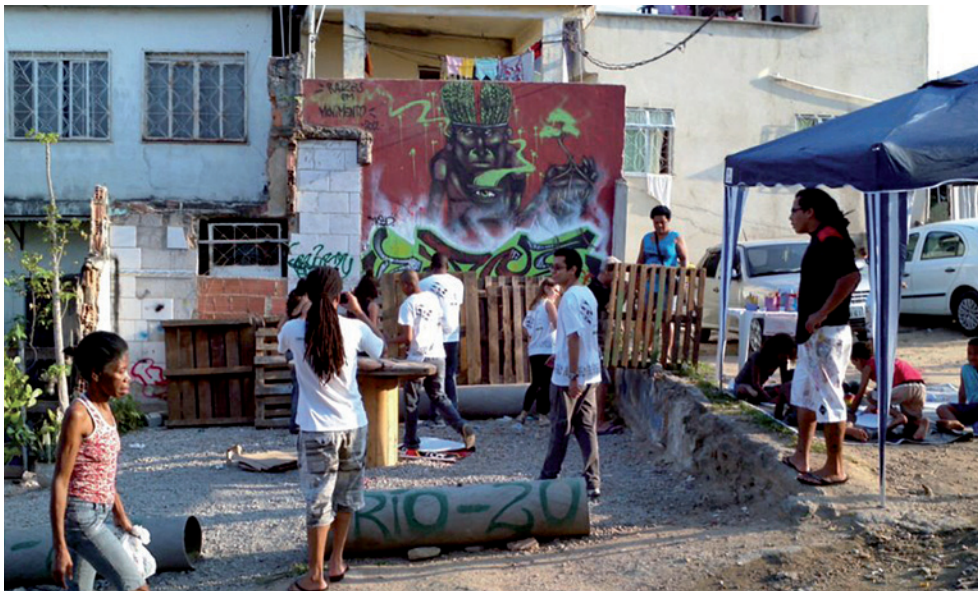
Fig.19: Mutirão de construção durante workshop de intervenções urbanas Reviu, do Instituto Raízes em Movimento. Foto: Raízes em Movimento/2012.
